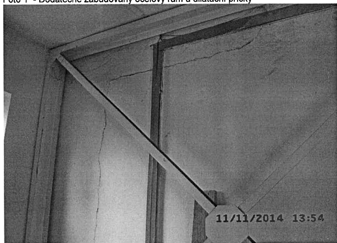
Foto 1 - Dodatečně zabudovaný ocelový rám u dilatační příčky
