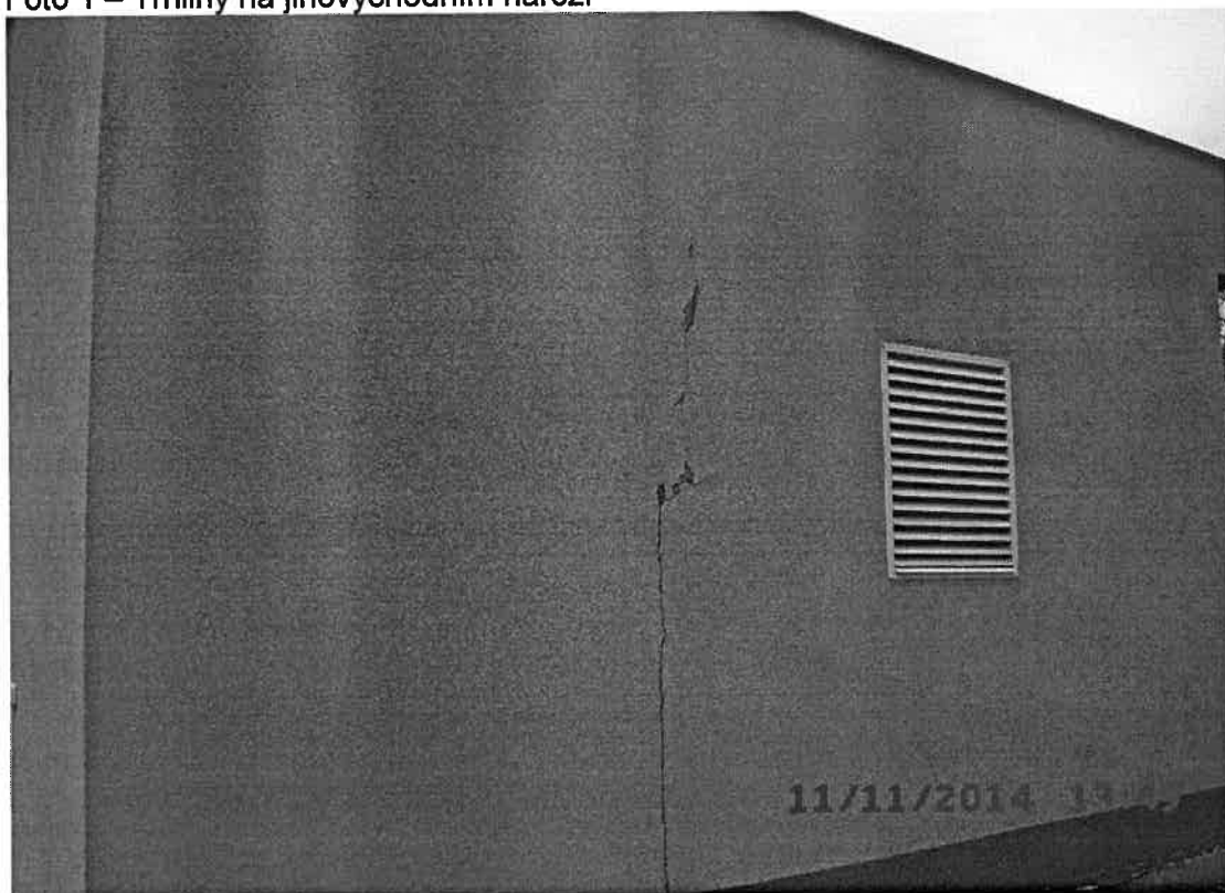
Foto 1 – Trhliny na jihovýchodním nároží
